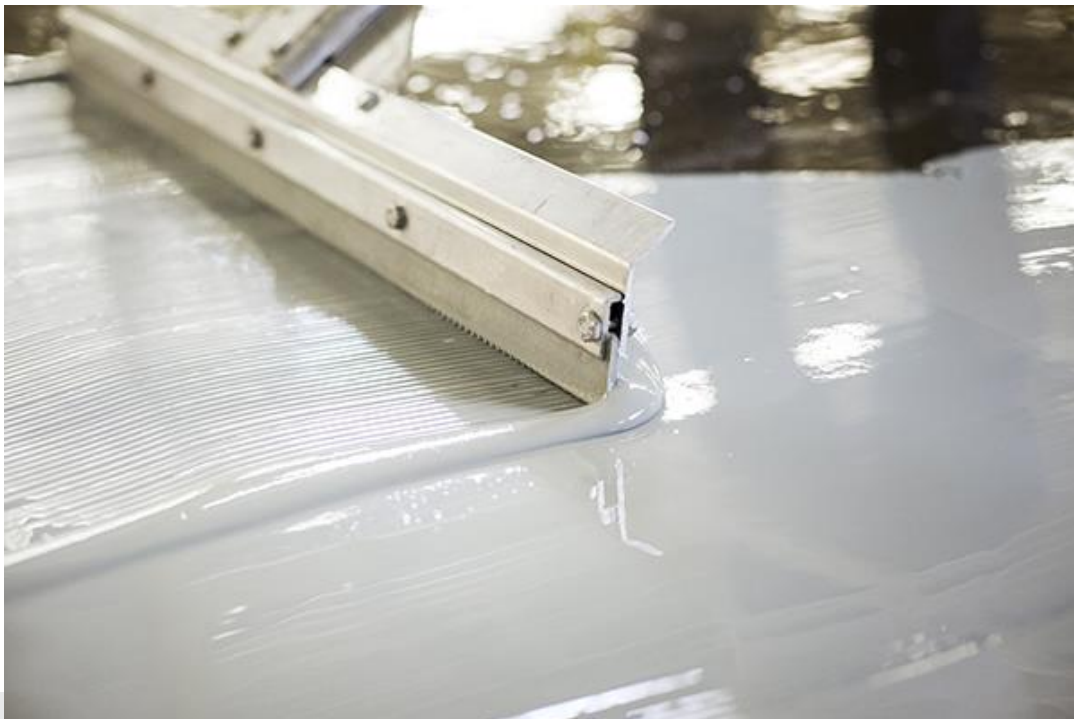
Foto: Aanbrengen vloeistofdichte beschermlaag.
