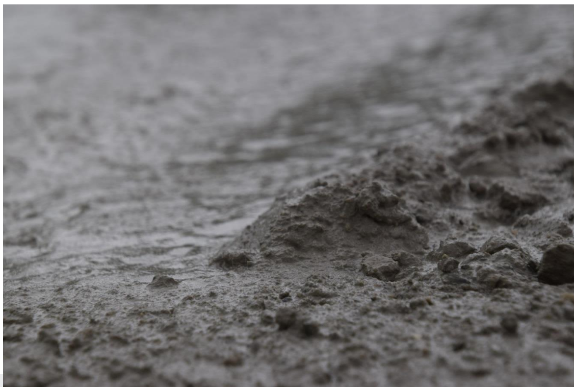
Foto: Detail betonmortel.
